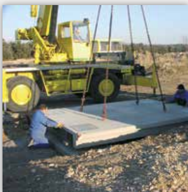
Instalacja wagi samochodowej
